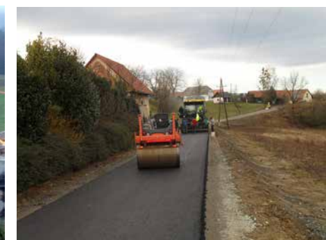
Sanierung der Fantscher Straße mit Einbau von Glasfaserkabel und Wasserleitung
