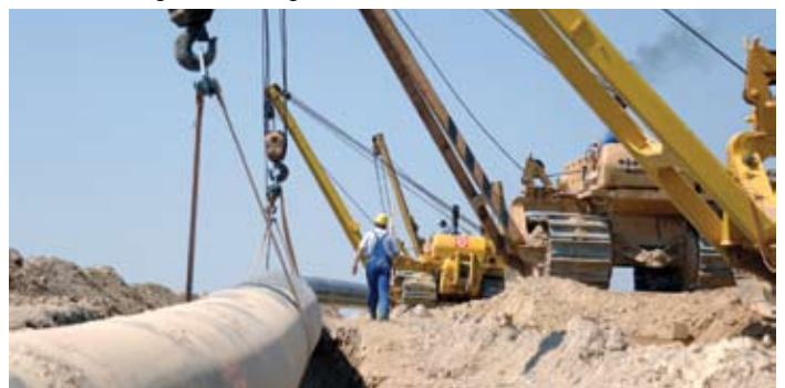
Bereits lange bevor Erdgas-Pipelines verlegt werden, werden ausführliche Gespräche mit den Anrainern geführt.
